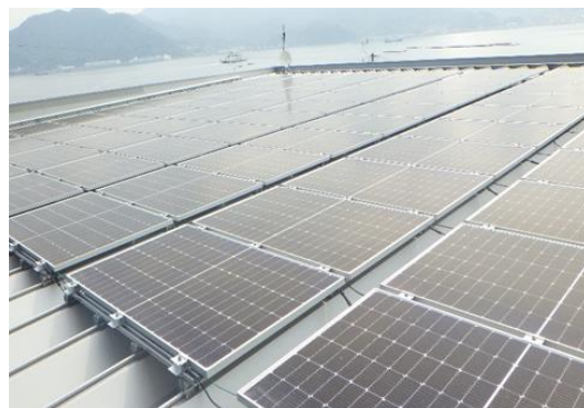
屋形石分工場に太陽光パネルを設置しました。(2022.4.17)
