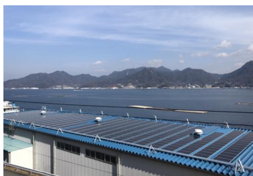
太陽光パネルを設置しました。(2021.2.20)
