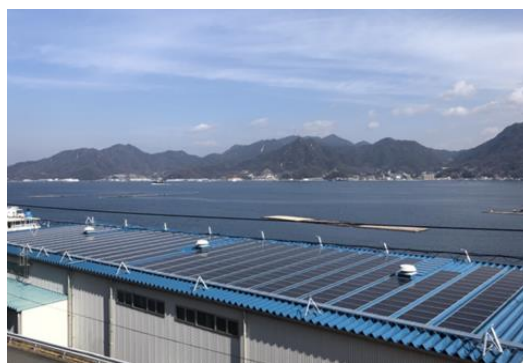
太陽光パネルを設置しました。(2021.2.20)
